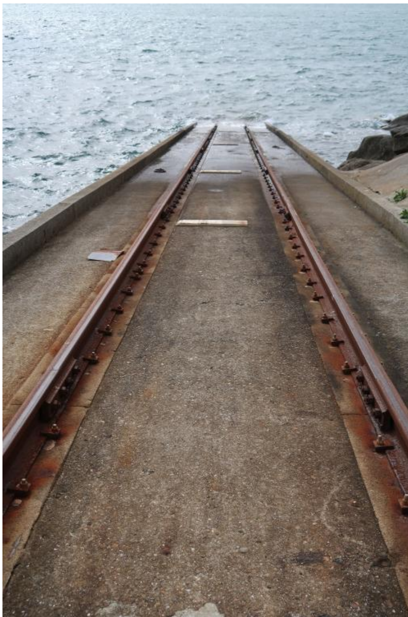
Cale SNSM : rampe de mise à l'eau du canot de sauvetage
