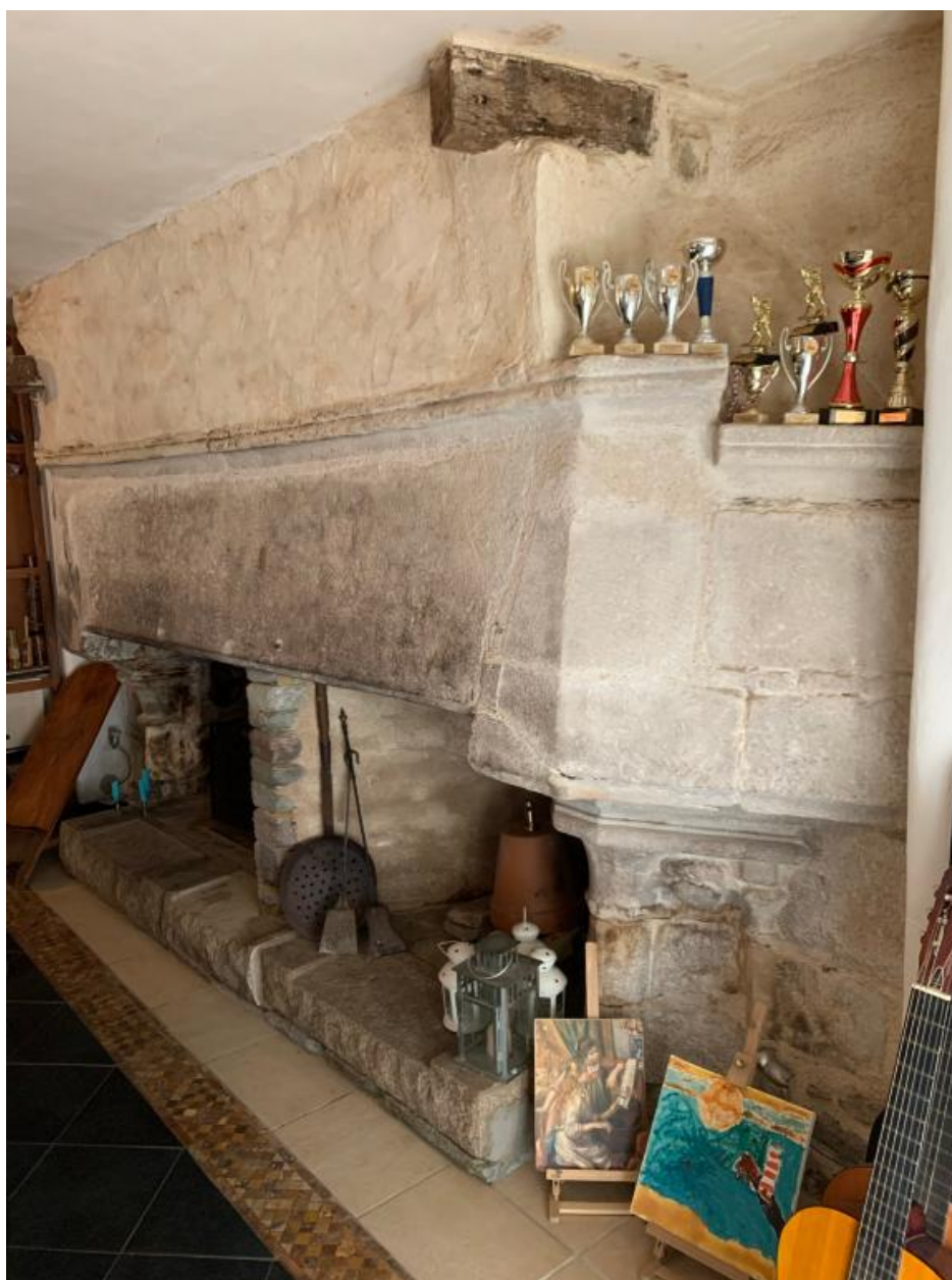
Partie ouest, rez-de-chaussée, cheminée
