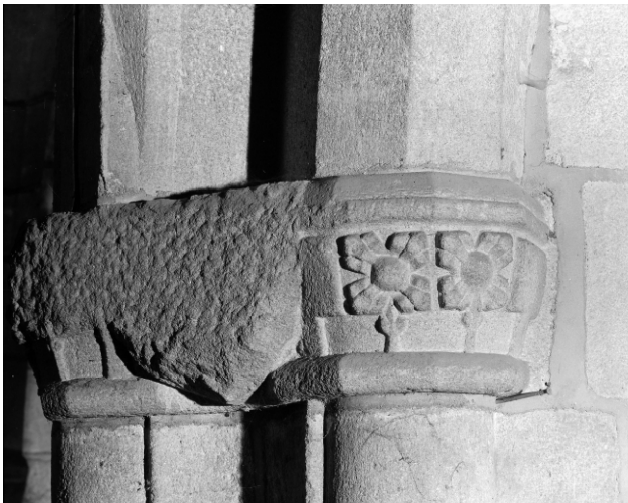
Nef, deuxième pile sud : chapiteau, vue de détail.
