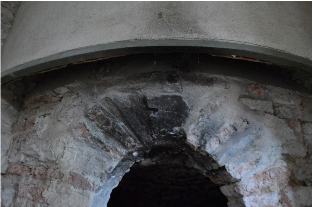
Détail d'un four à pain au sous-sol
