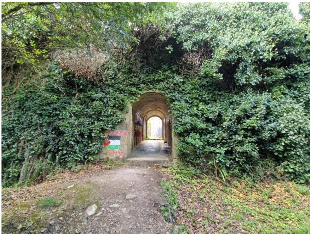
Vue de la poterne traversant la redoute depuis le fossé nord-est (état en 2024)
