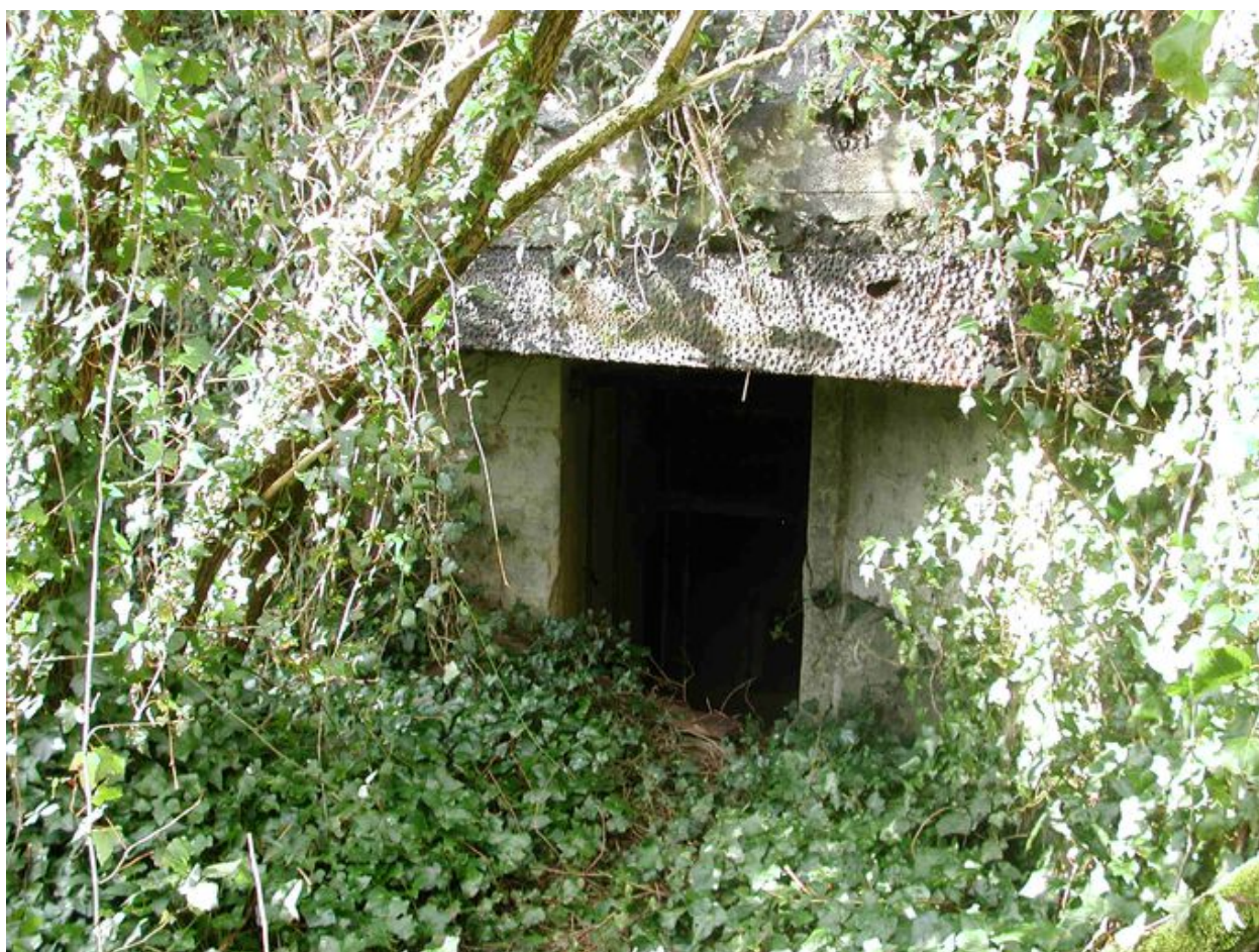
Vue de la casemate à toit blindé armée d'un canon de 75 mm Pak 40 (Type 626) (B 109) : entrée
