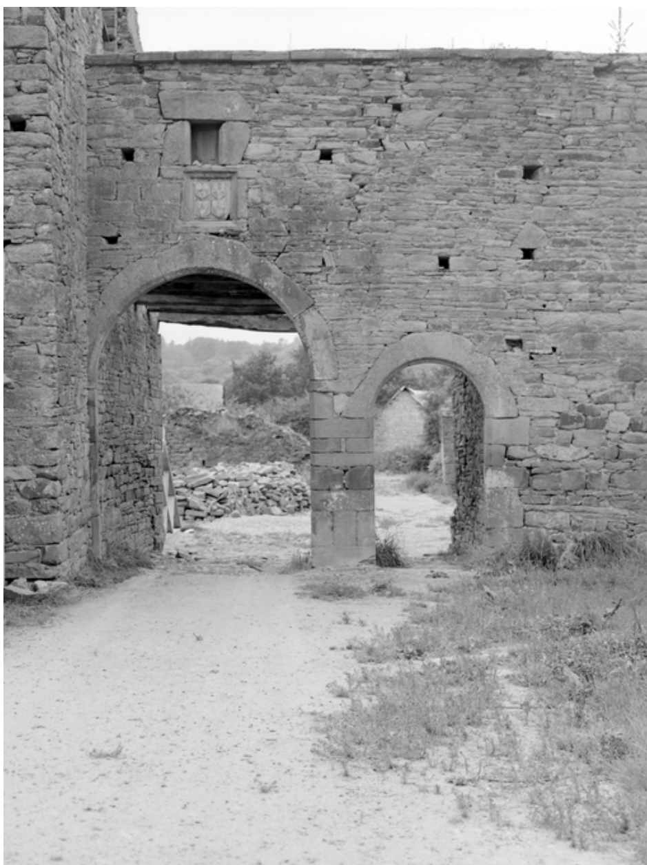
Entrée du manoir : vue du nord-est
