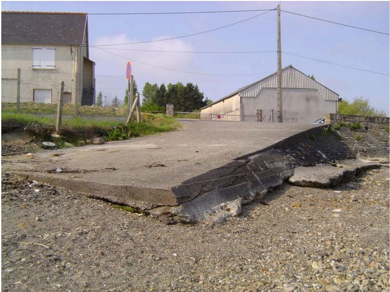
Cale de l'extrémité méridionale de la digue-route
