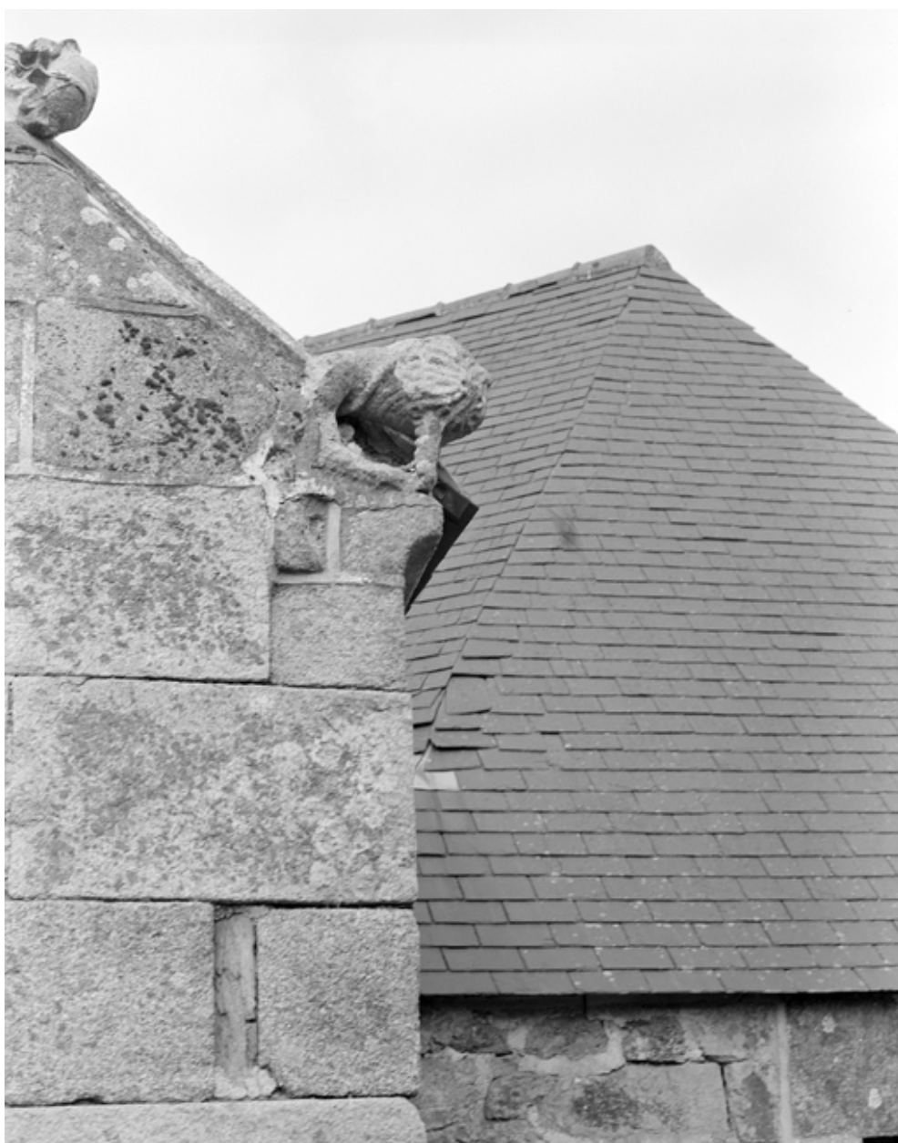
Choeur, mur est, crossette à la base du rampant nord
