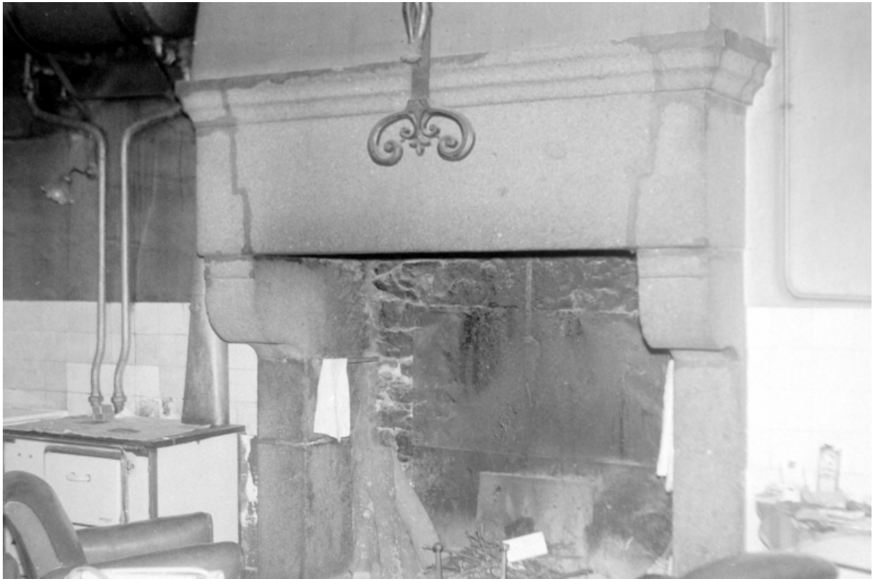
Cheminée, vue générale.
