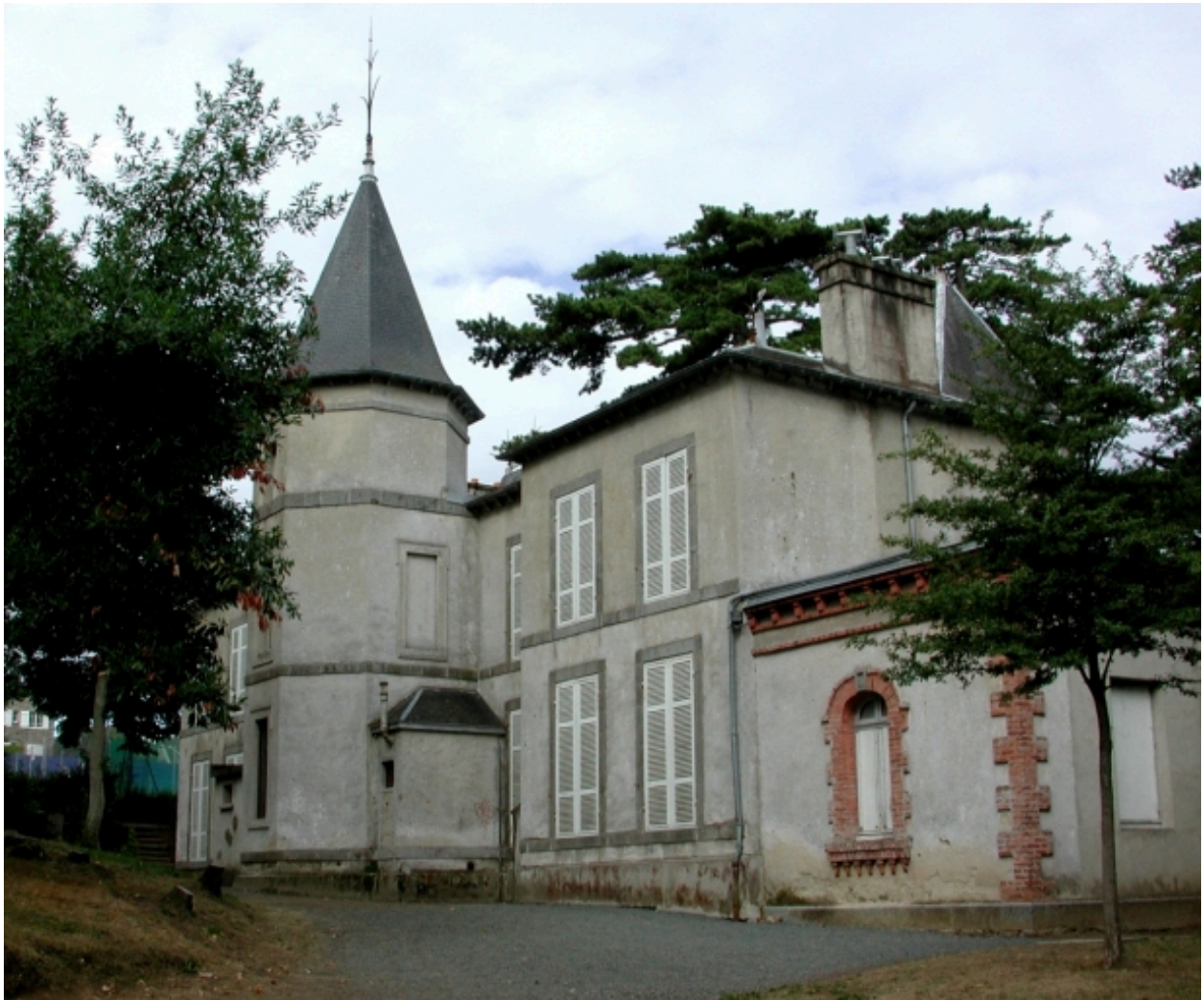
Vue générale de la façade postérieure
