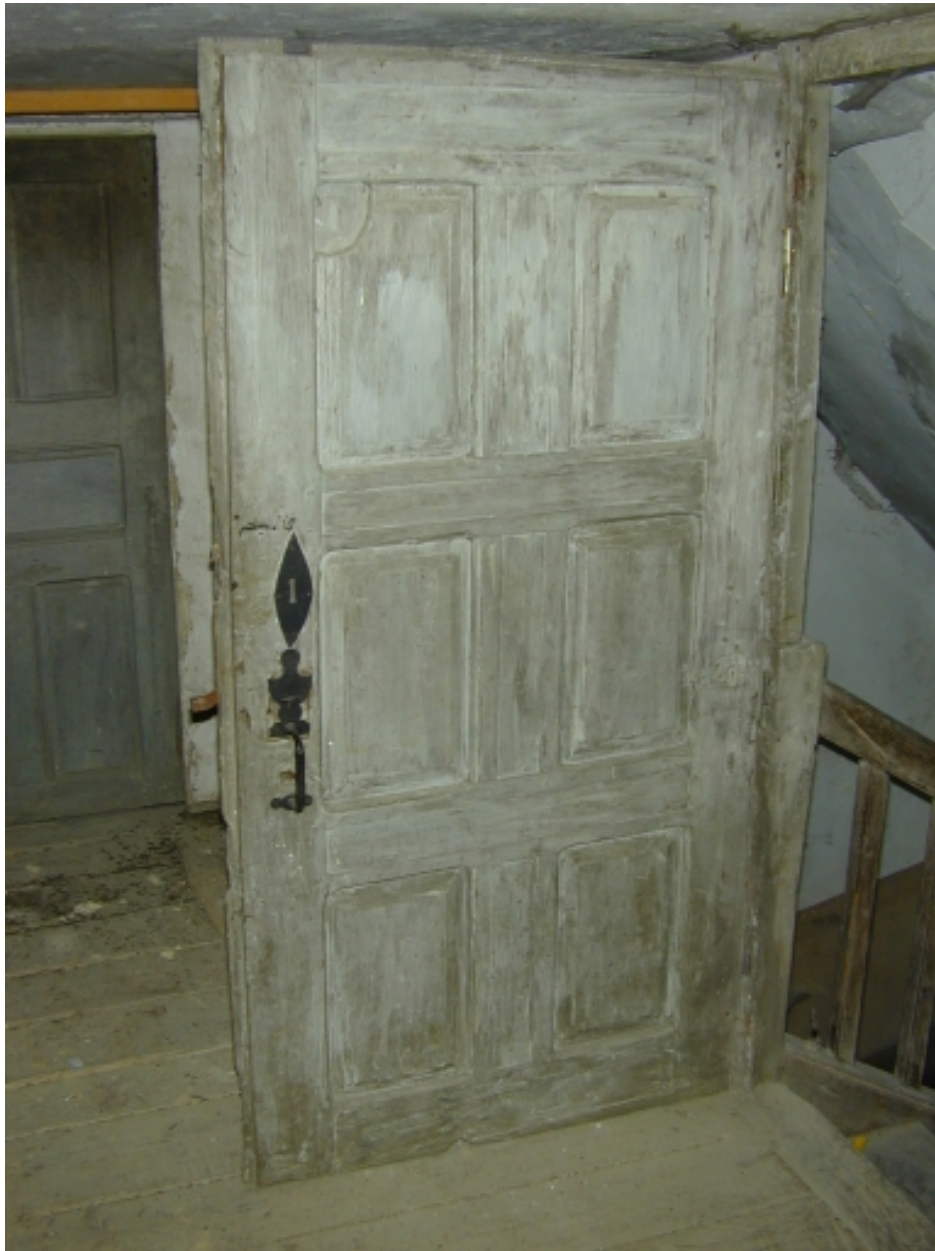
Logis, intérieur, porte des combles : vue générale
