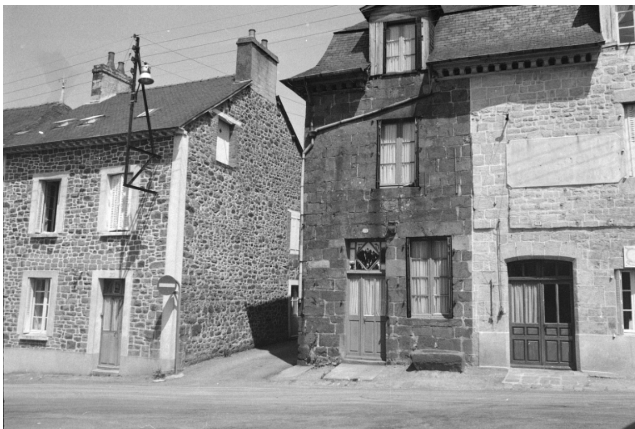
Partie ouest de la façade sud
