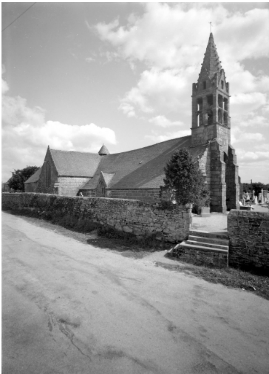
Vue prise du nord-ouest
