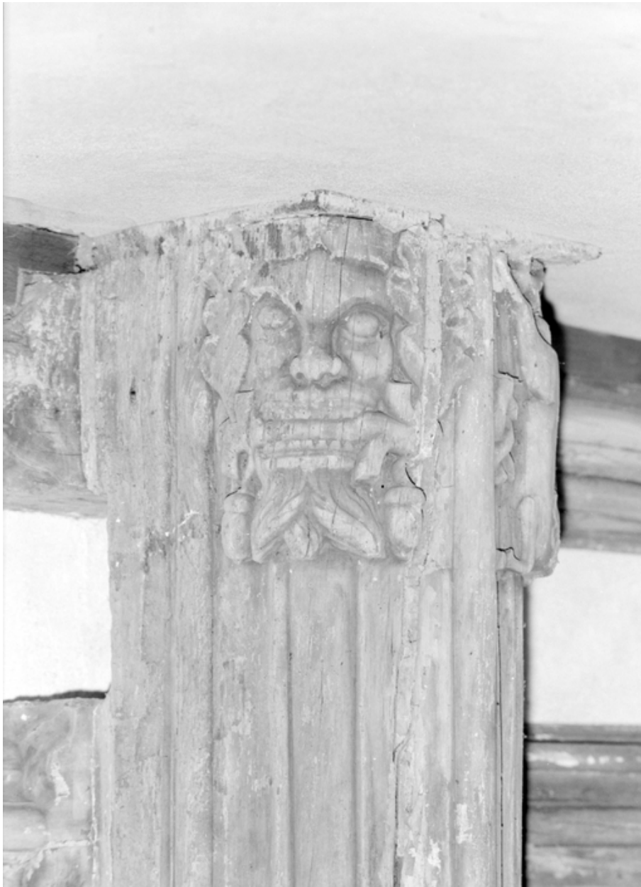
Tour sud, poutre moulurée et décorée : vue générale (état en 1984)
