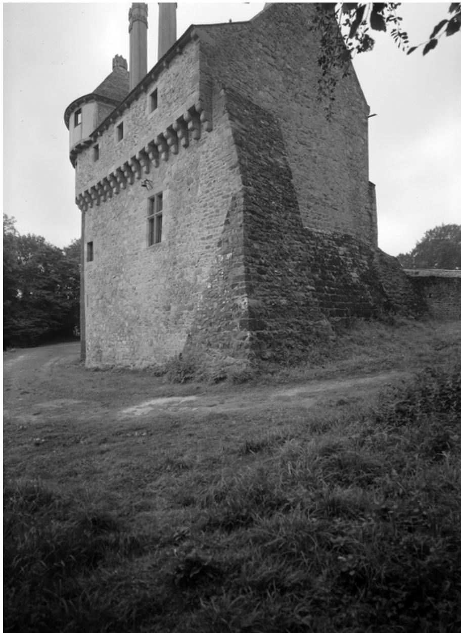
Vue générale depuis le nord-ouest : pignon nord (état en 1974). Traversant le pignon, les vestiges de l'enceinte du château primitif ; le pignon est doté d'un contrefort taluté
