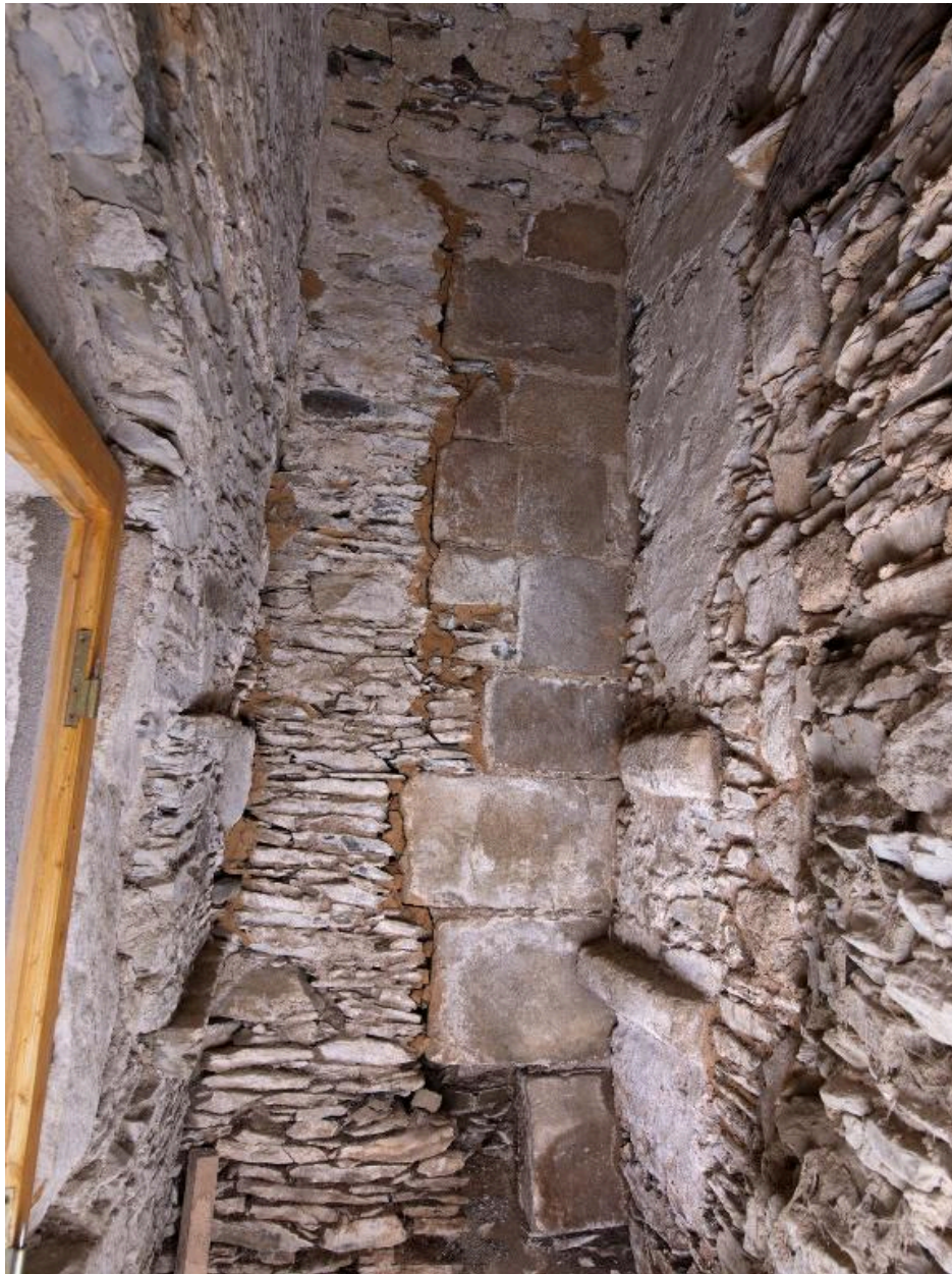
Construction d'angle nord-est. Sas. Détail
