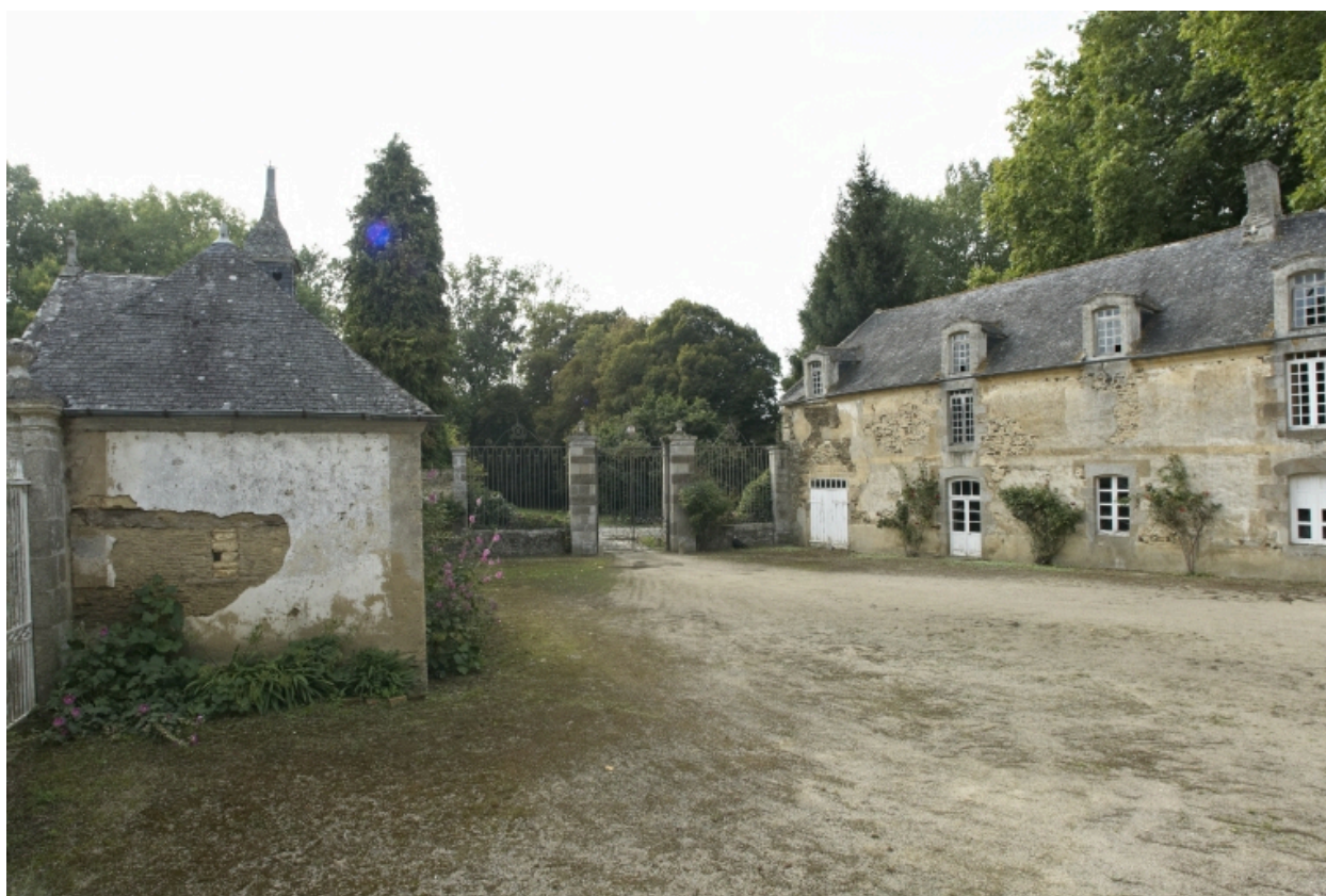
La cour de l'ouest vers l'est
