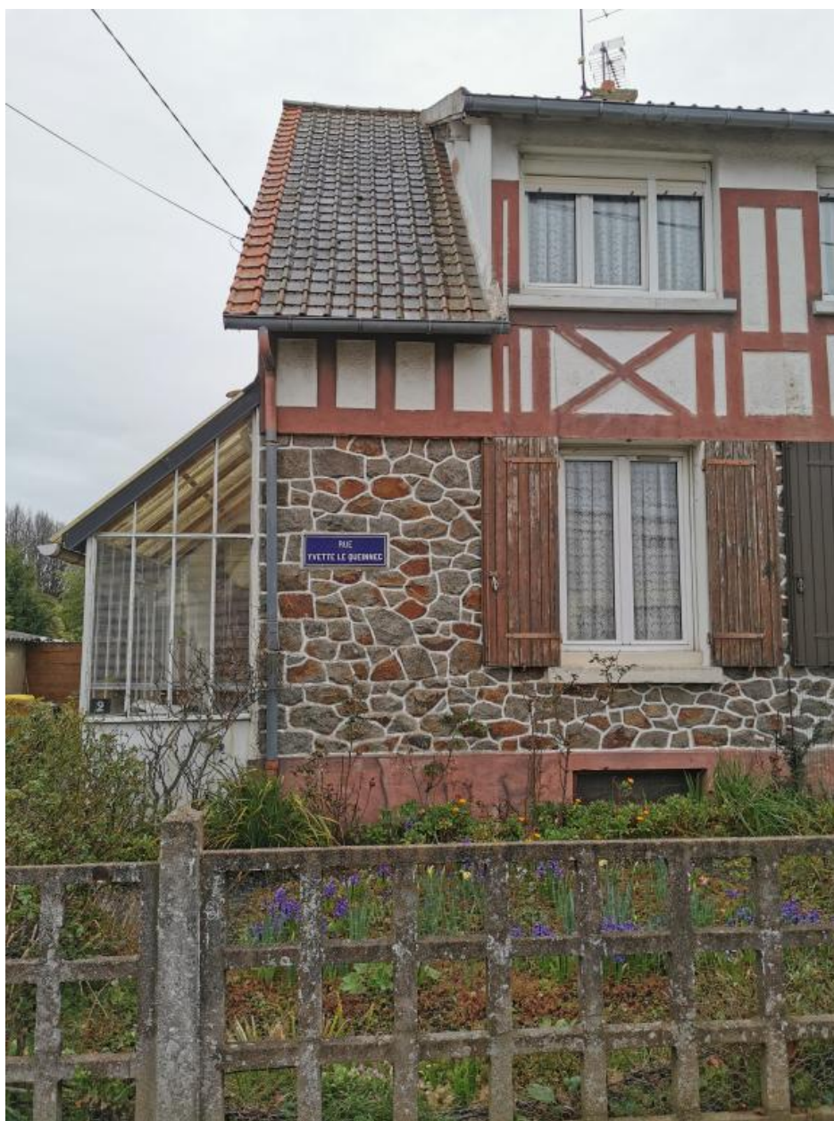
Vue de détail maison jumelée
