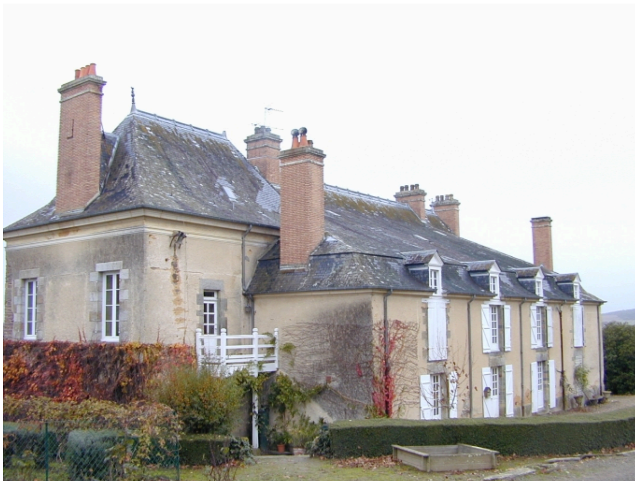
Corps principal, pavillon et ancien logis : vue générale sud-est
