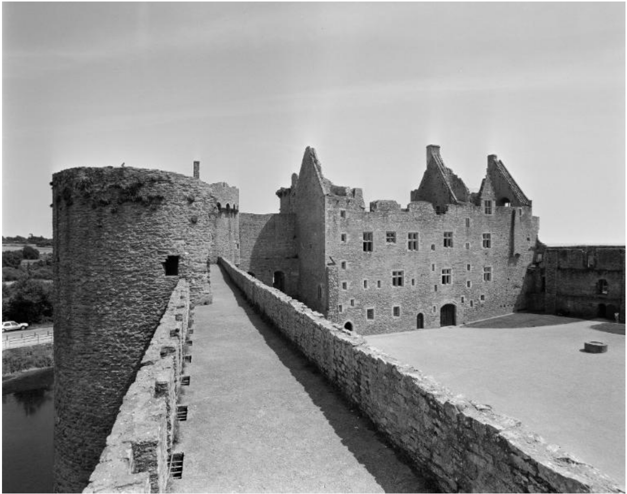
Château fort, logis est, élévation ouest, vue prise de la courtine nord.
