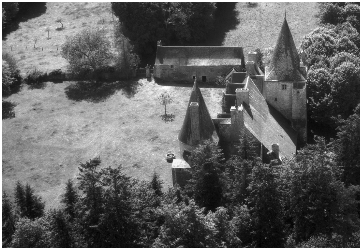
Vue générale prise de l'est
