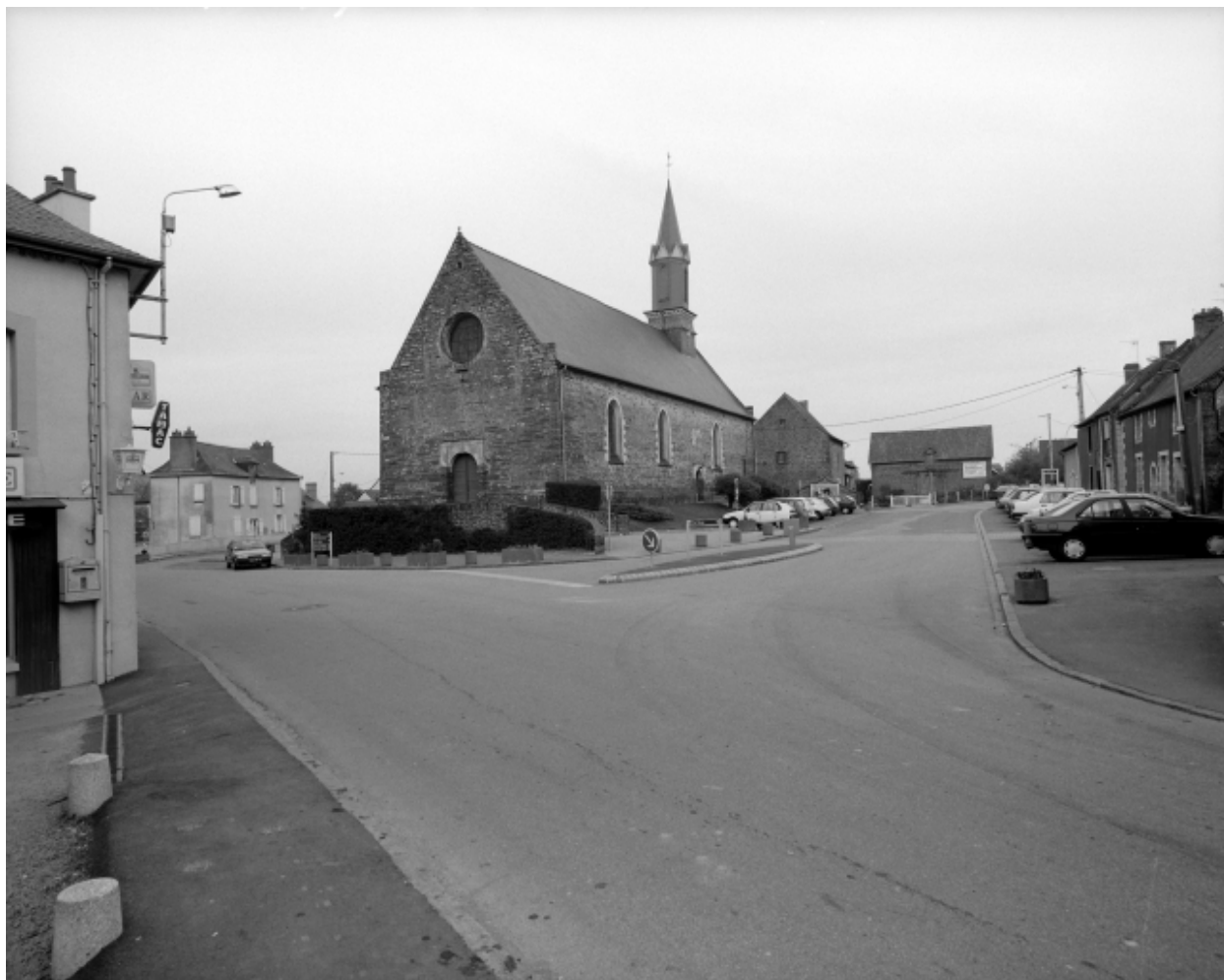
Elévation Sud-Ouest : vue générale
