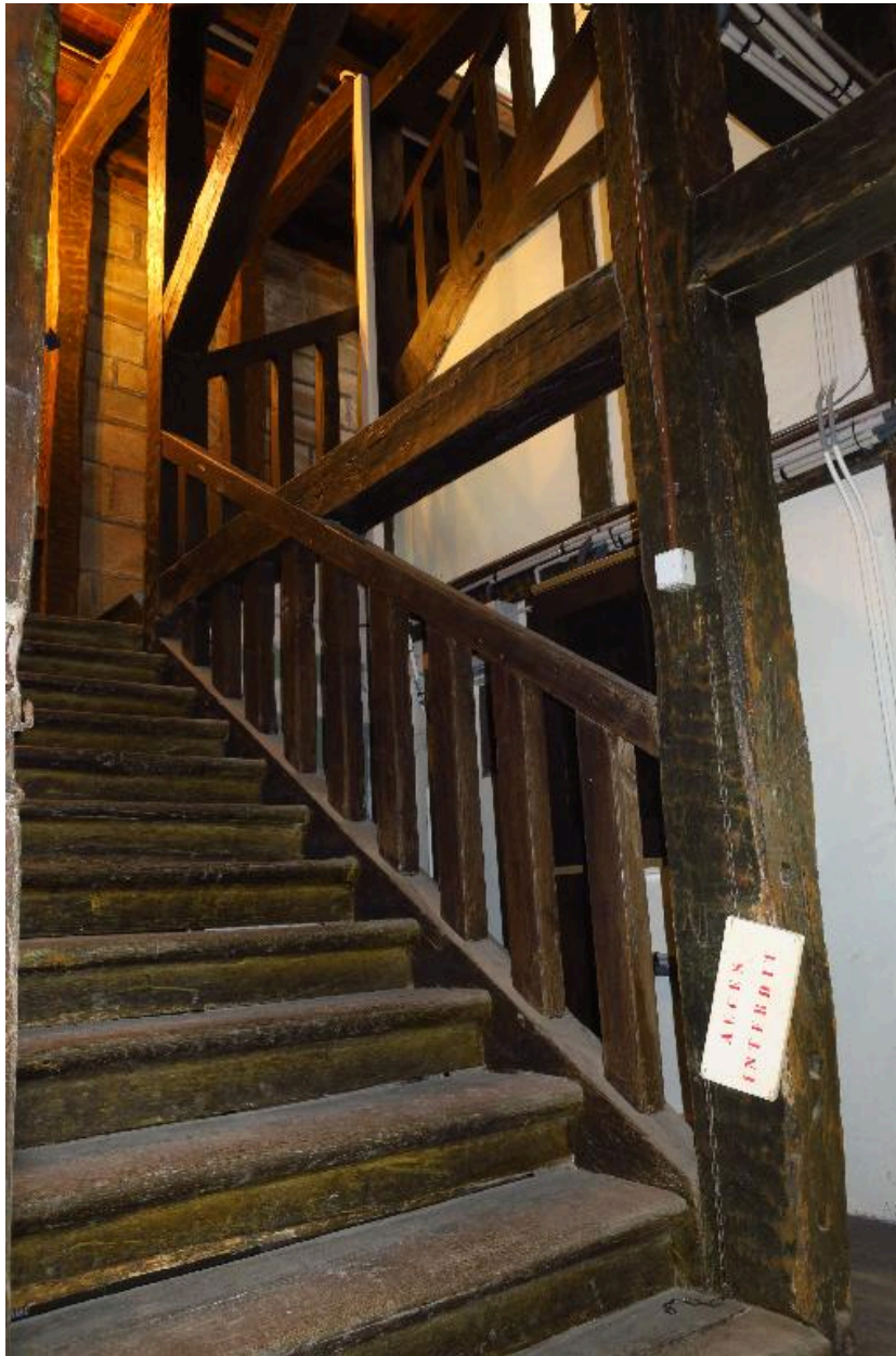
Saint-Pierre-Quiberon, fort de Penthievre, caserne défensive, cage d'escalier à pans de bois.
