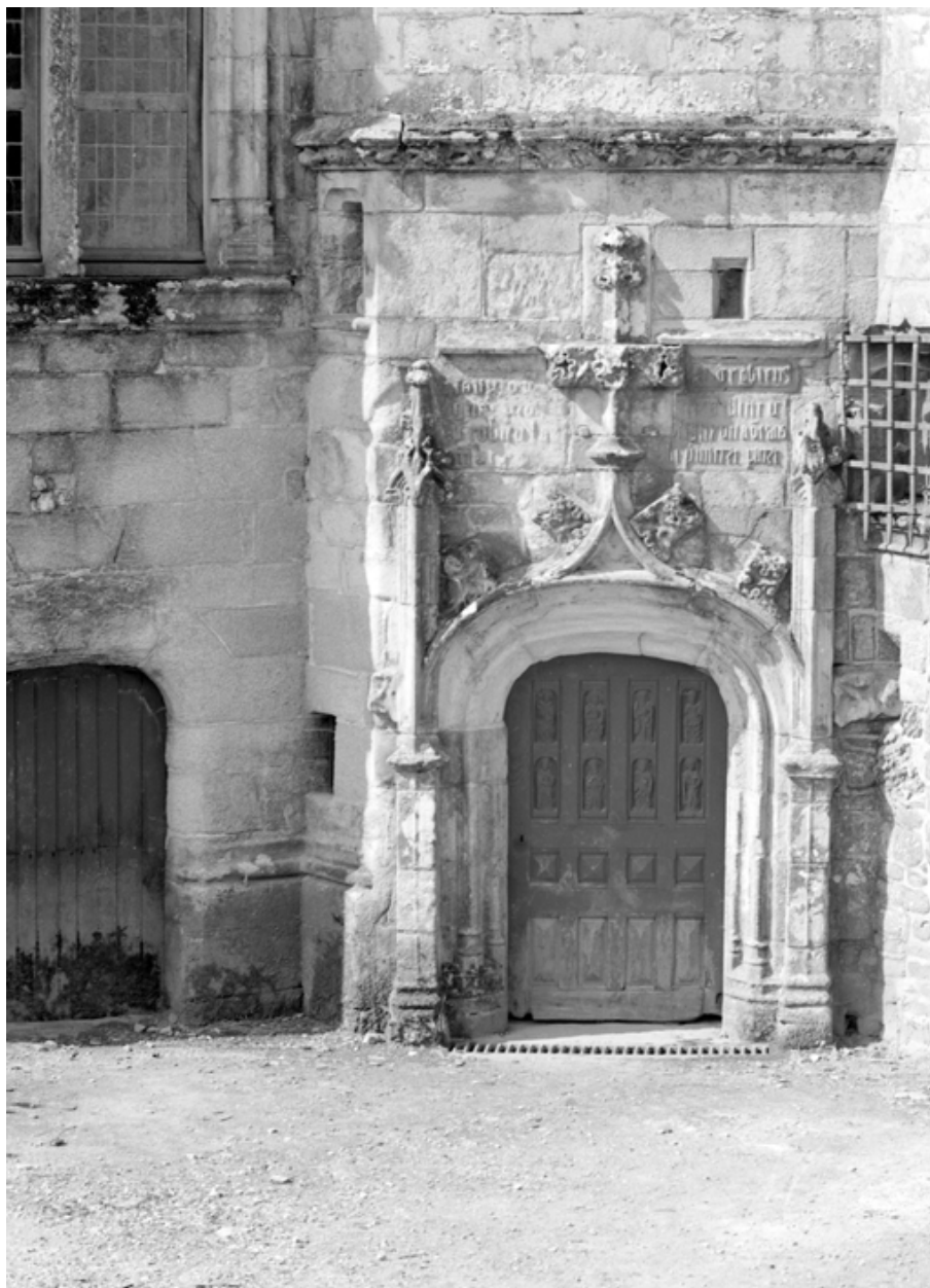
Tour d'escalier, porte : vue générale (état en 1984)
