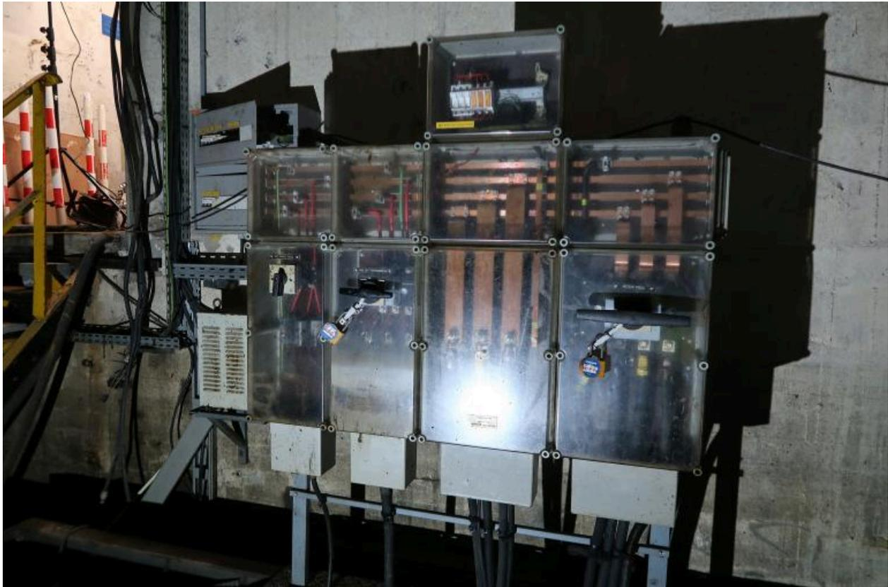
Vue des armoires électriques (n° 2). On peut lire : ECLAIRAGE TREUIL, TABLEAU TRANSBORDEUR, Alimentation générale provenant de la centrale, MOTEUR TREUIL...
