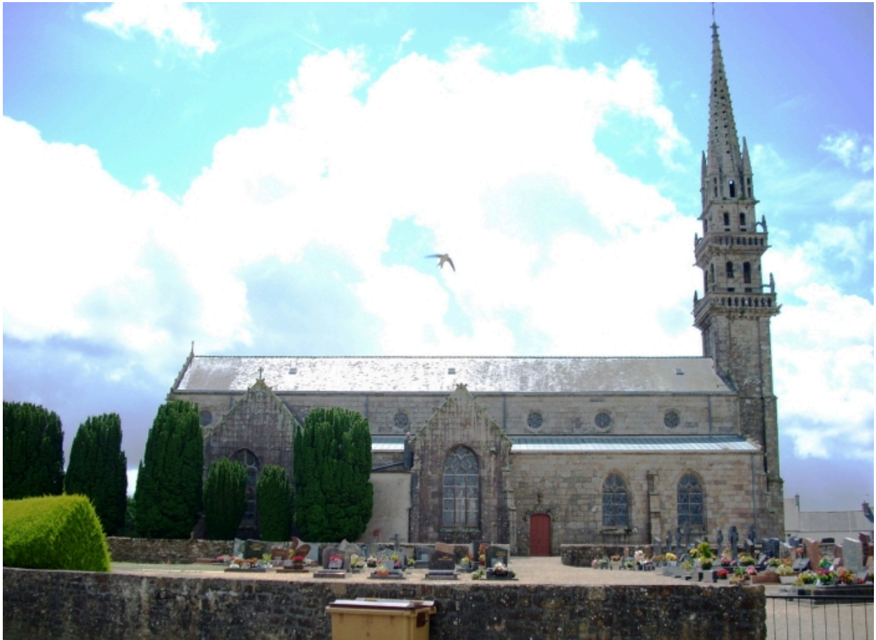
Plouneventer, église paroissiale Saint-Néventer : élévation nord
