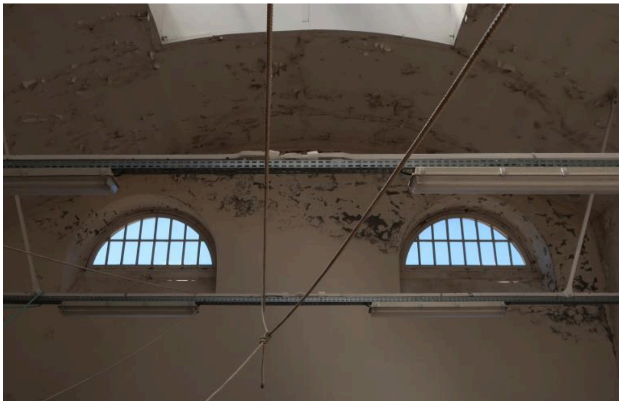
Vue intérieure : baies du pignon ouest (état en 2022)
