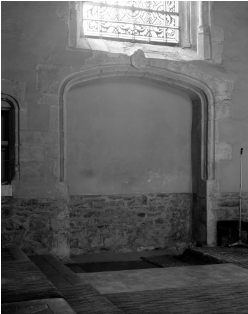
Choeur, mur nord, détail de l'enfeu.
