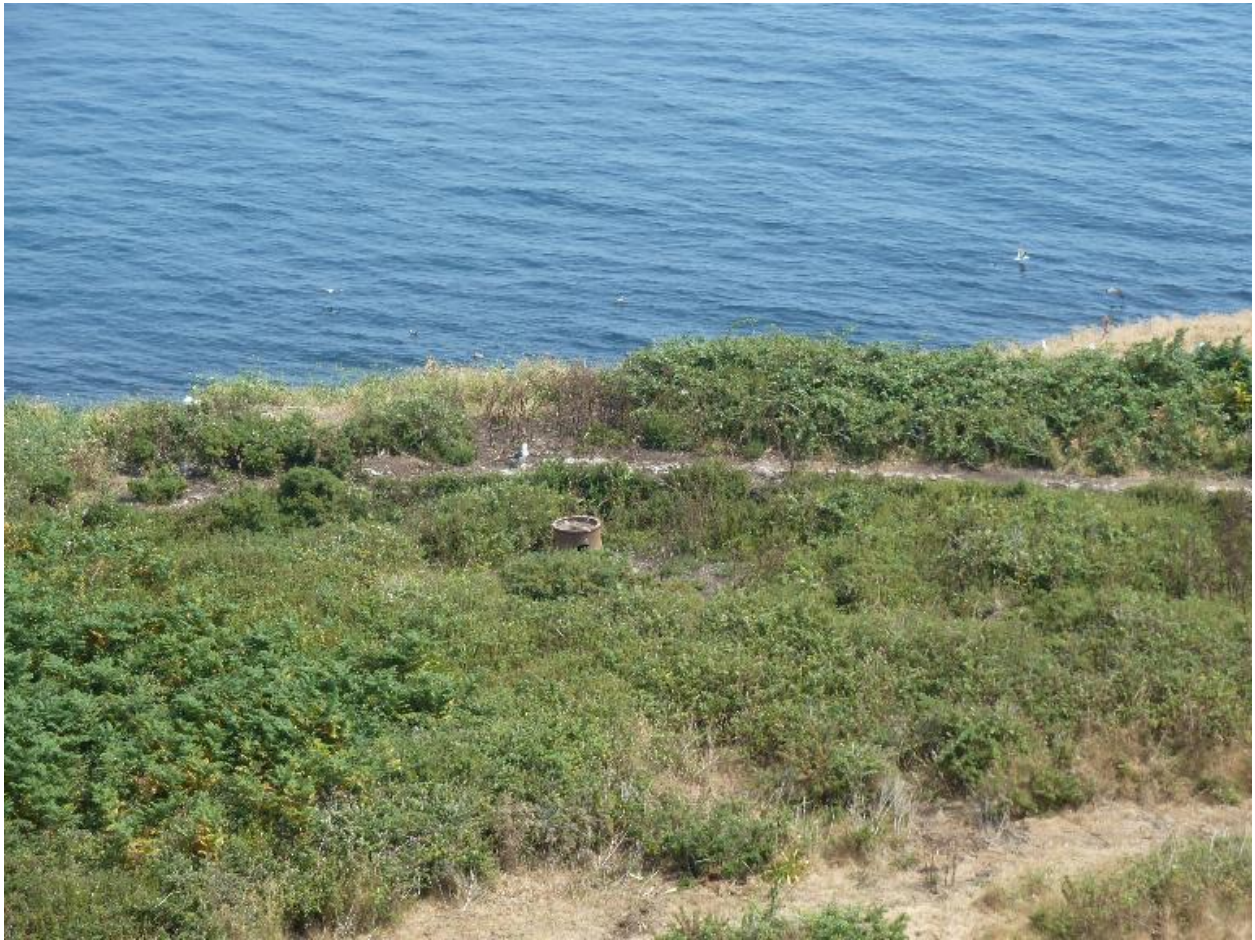
Archipel de Glénan, batterie de Penfret, mur de genouillère de l'épaulement et affût de canon de 95 mm.
