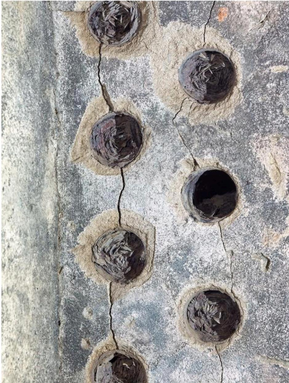
Vue du bunker - abri de type 485 long pour radar Mammout : passages de câble de la salle des compensateurs au puits d'antenne sud-ouest via un sas étanche
