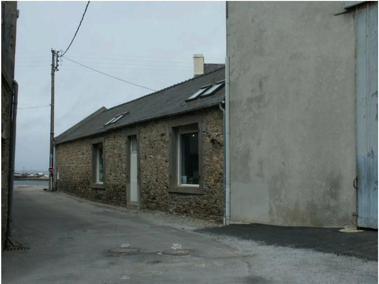
Vue latérale de l'ancien Grand Magasin
