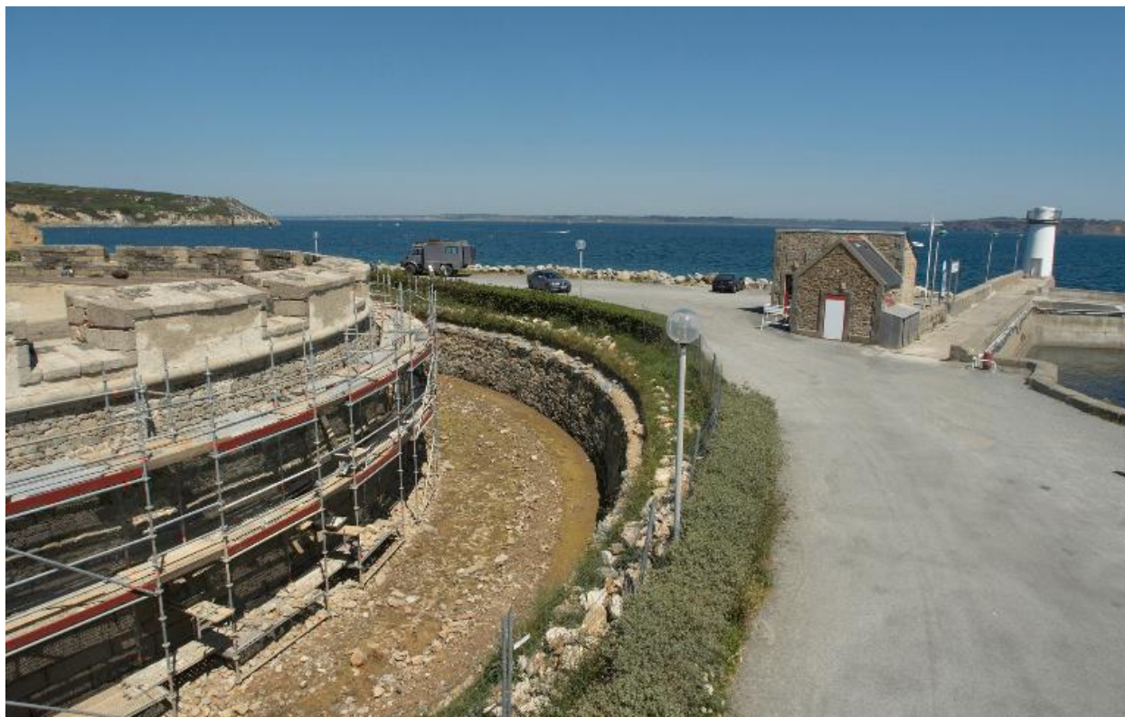
Camaret-sur-Mer : vue de la tour Vauban, restauration de l'escarpe de la batterie
