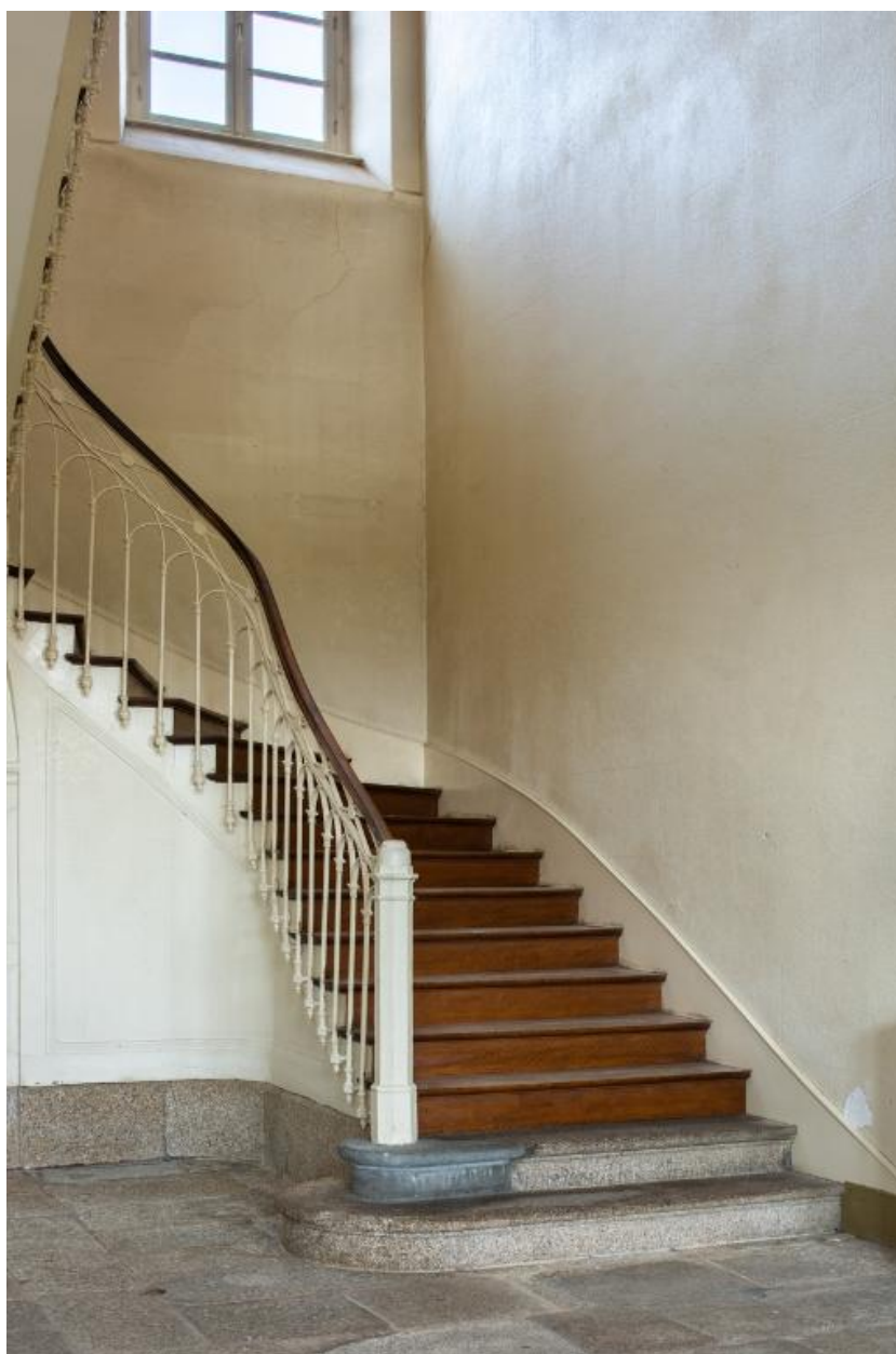
Escalier au rez-de-chaussée
