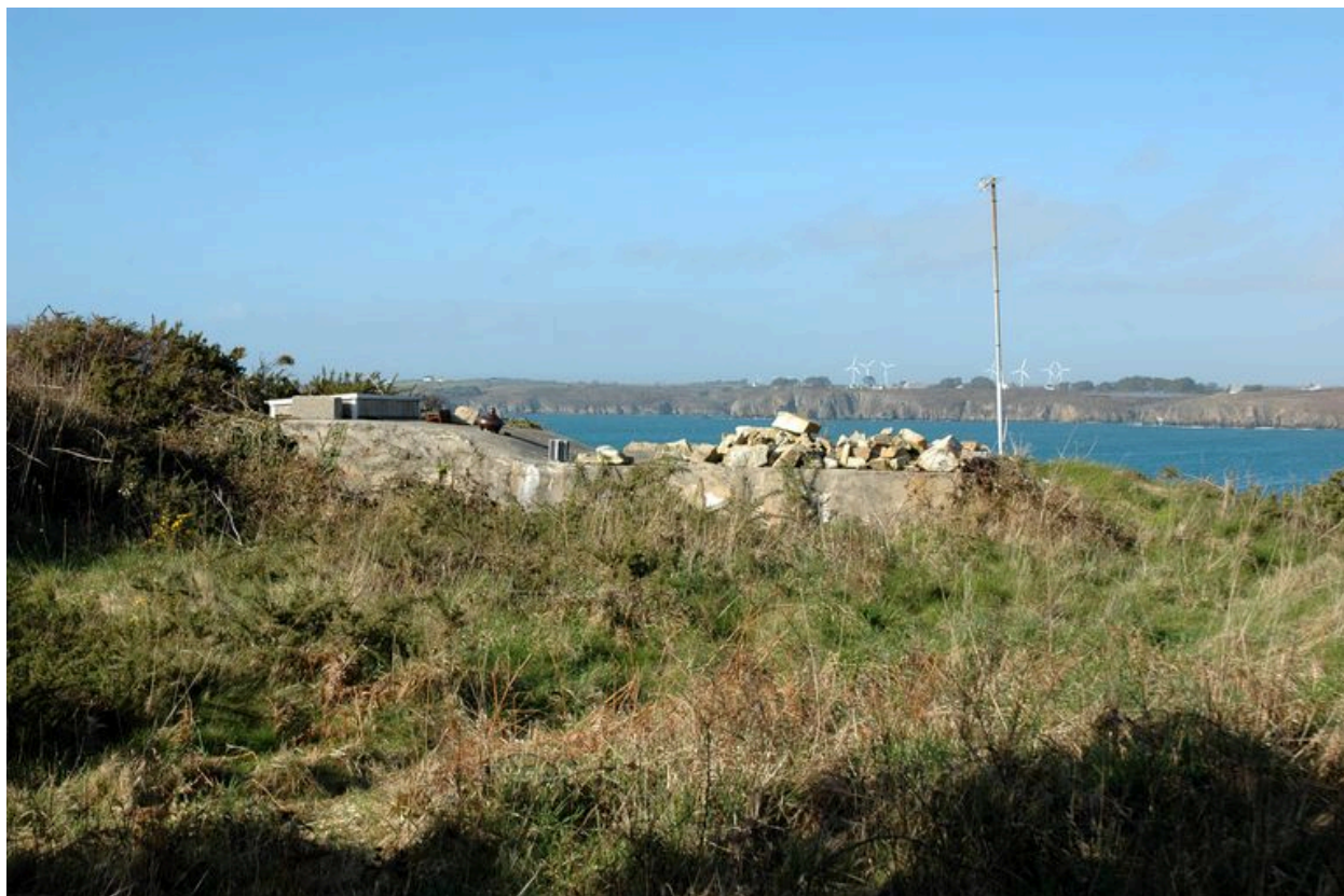
Vue de l'un des bunkers situés à proximité de la batterie de Treize
