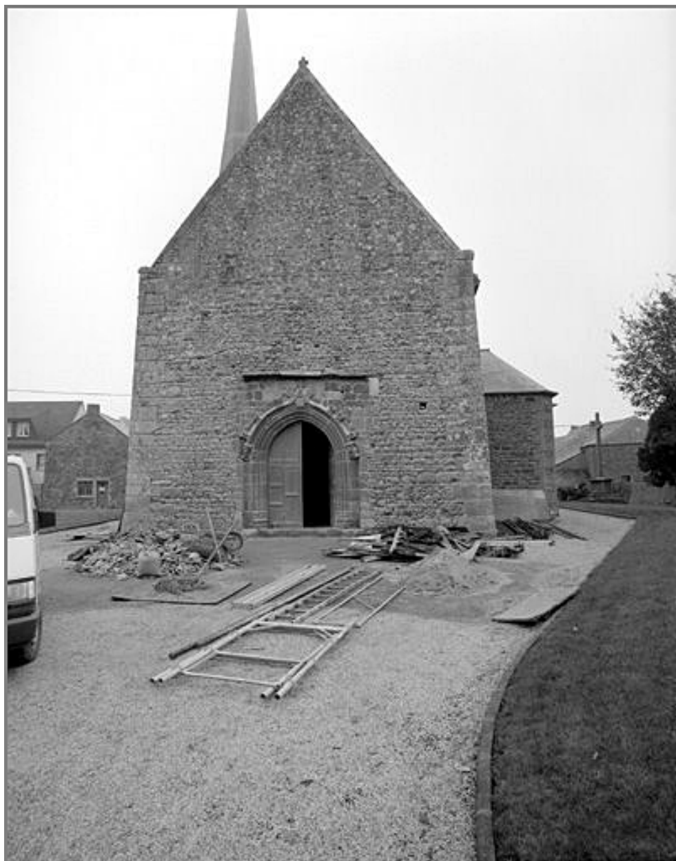
Elévation Ouest : vue générale avant restauration
