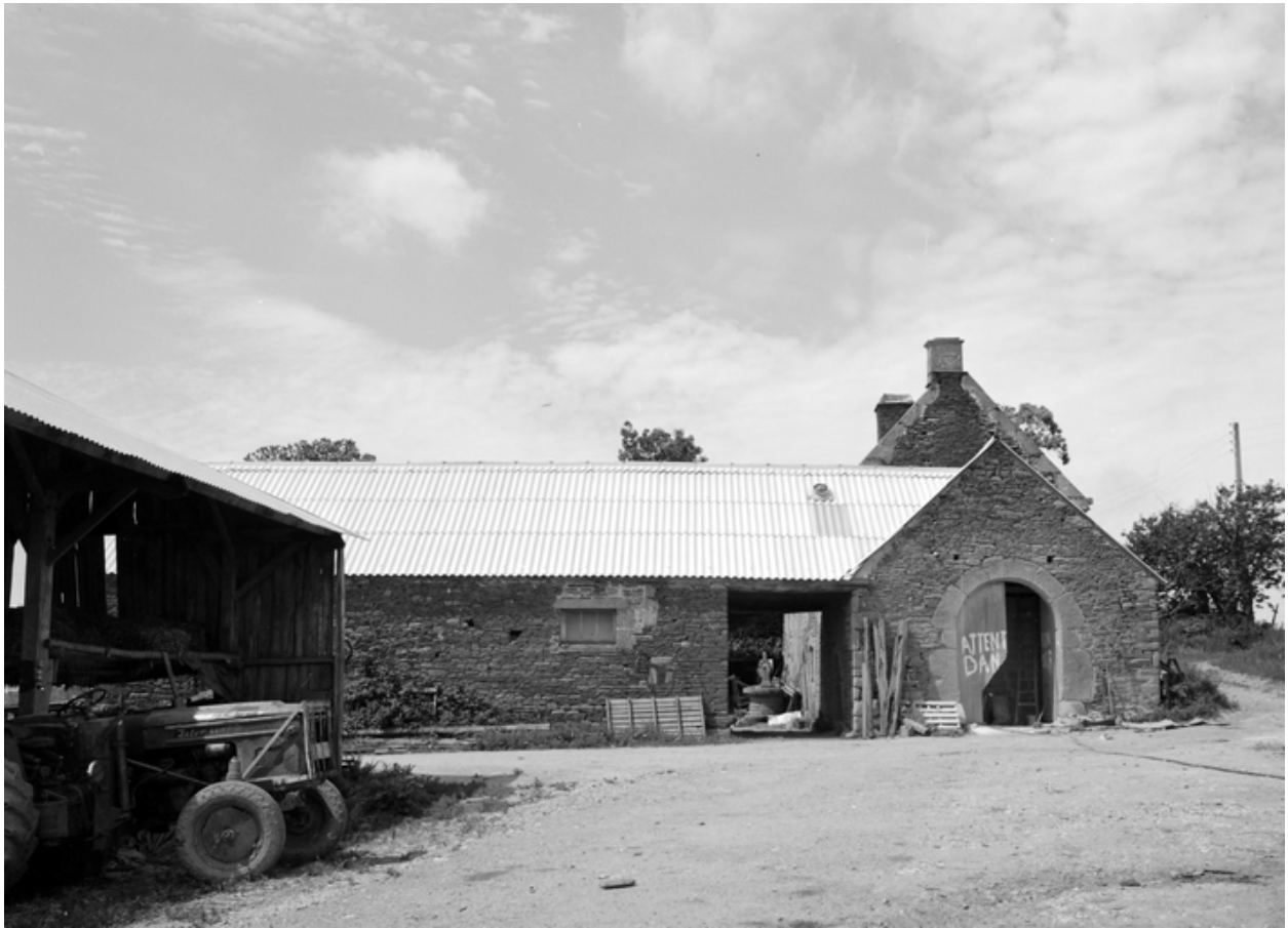
Vue générale des communs
