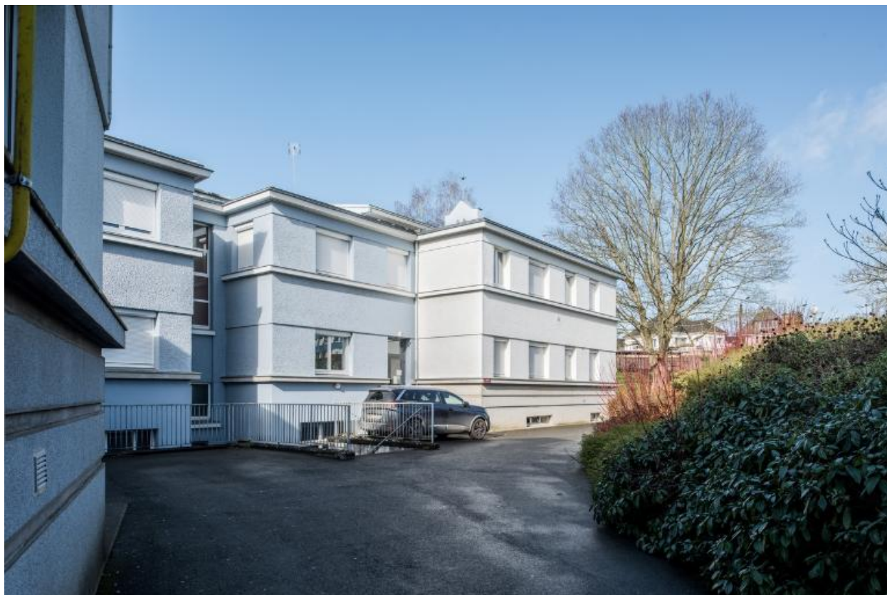
Bâtiment C, aile sud, façade arrière (ouest) : extension (Albert Hec et Roger Besnard, architectes, 1966).
