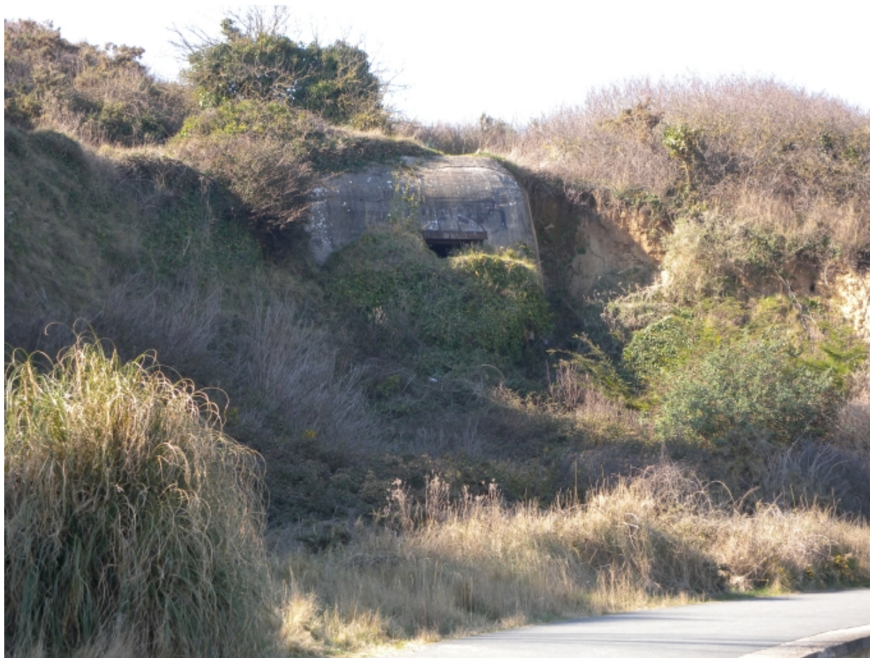
Vue du blockhaus situé à l'extrémité Ouest de la plage des Rosaires
