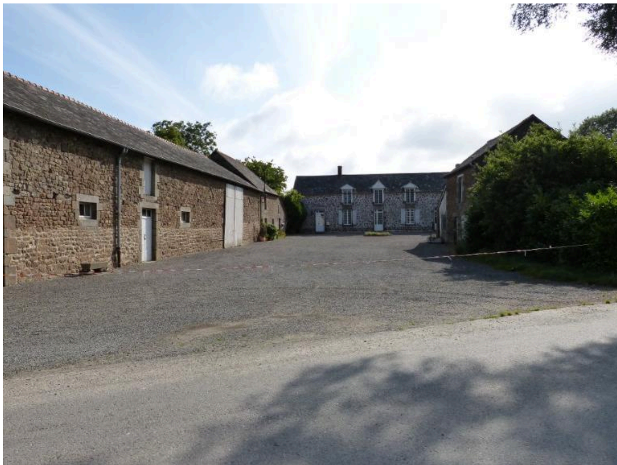
Vue d'ensemble ouest
