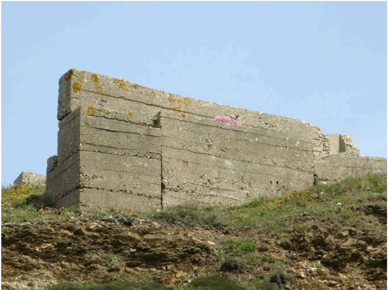
Poste de chargement de galets
