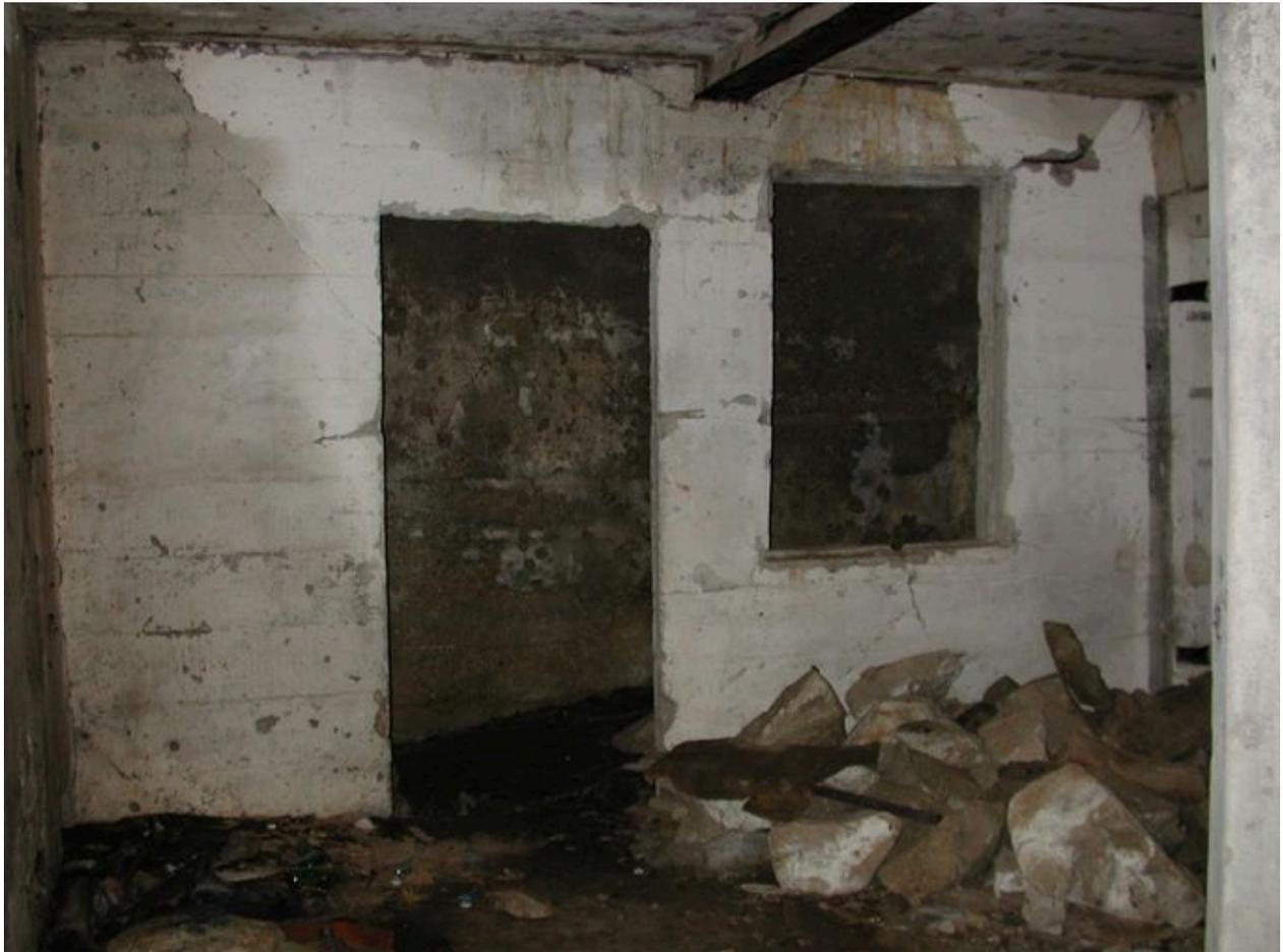
Vue de l'abri aménagé dans le rocher du Kernic : porte et fenêtre (état en 2002). Le mur est construit en béton armé de faible épaisseur
