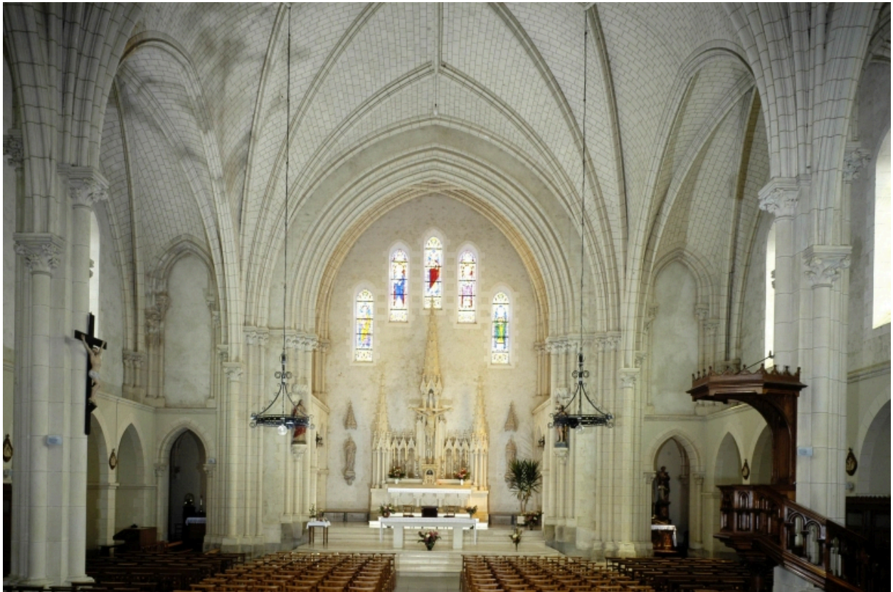
Intérieur : vue générale vers le chœur.
