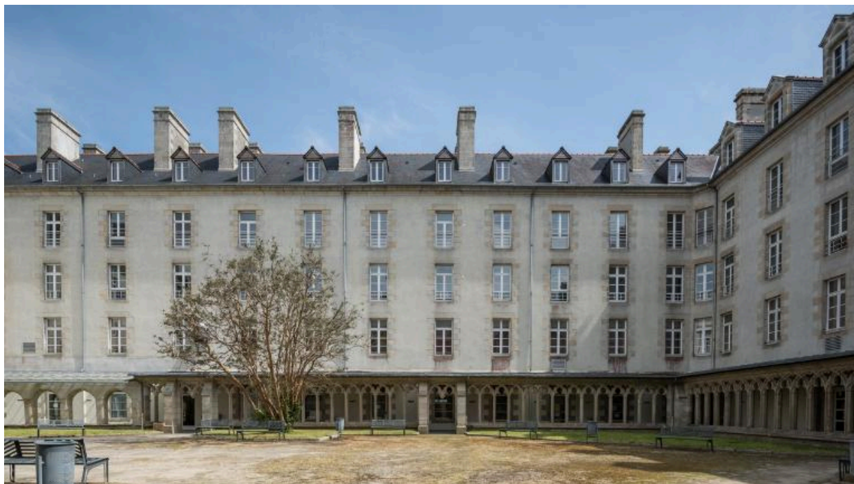
Vue de la cour de l'ancien séminaire, prise face à l'aile sud-est.
