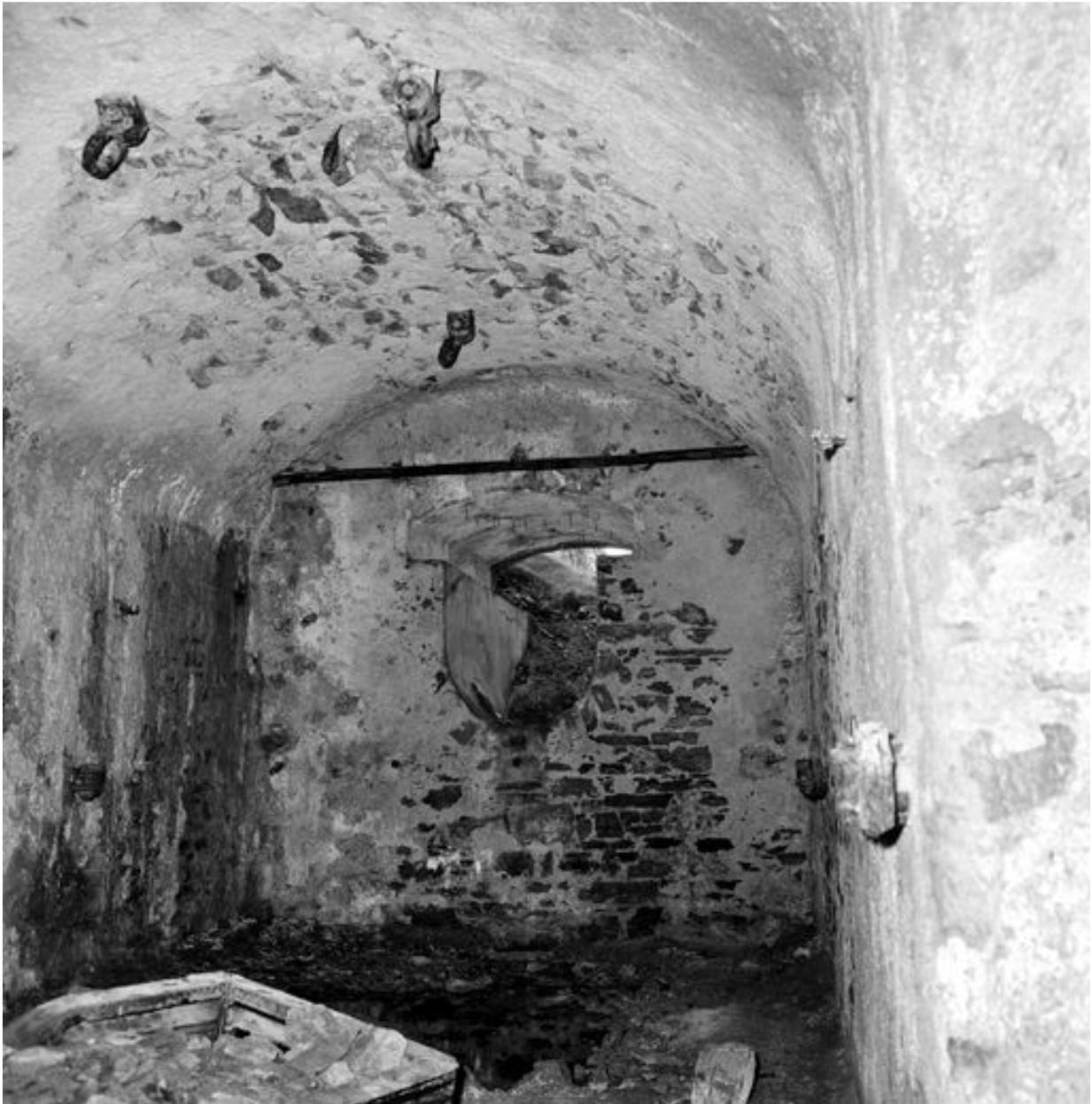
Vue de la chambre de tir ouest (état en 1969). Son embarsure est en partie obstruée par un éboulement
