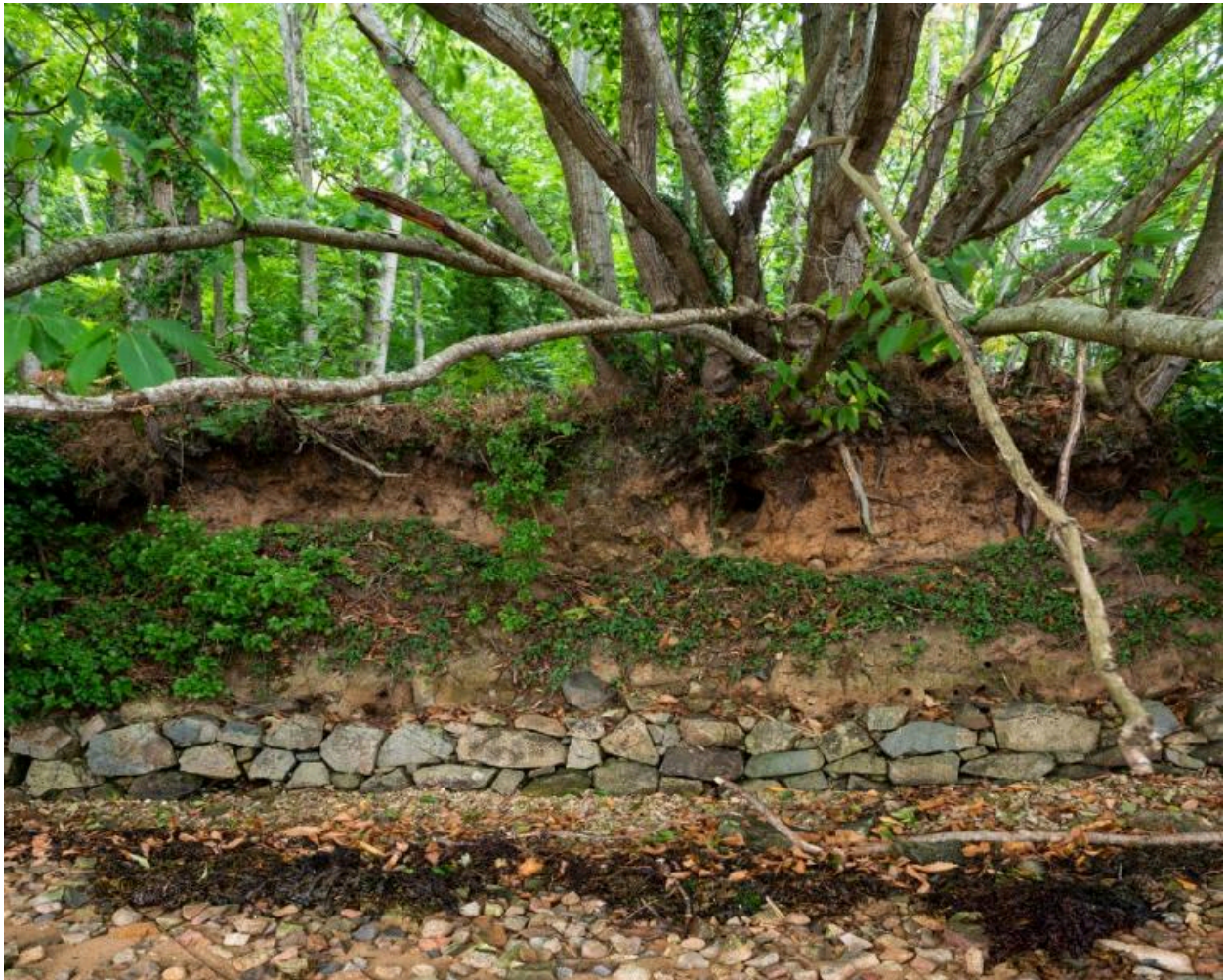
Mur de soutènement retenant les terres d'une forêt sur la rive ouest de la baie de l'Enfer
