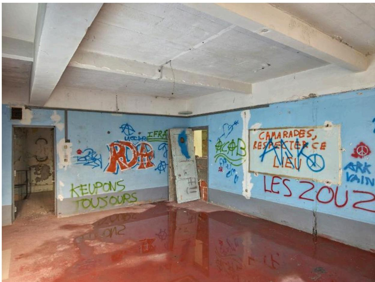
Vue de l'une des pièces du troisième étage : salle de calsse. La dalle de l'étage de comble repose sur des poutres en béton
