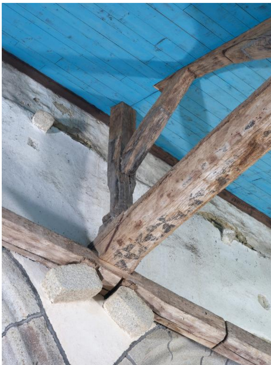
Charpente du bas côté sud : décor gironné
