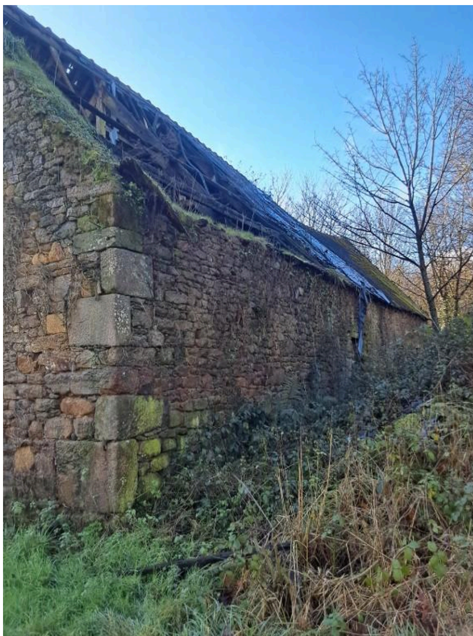
Dépendances, la grange, mur ouest
