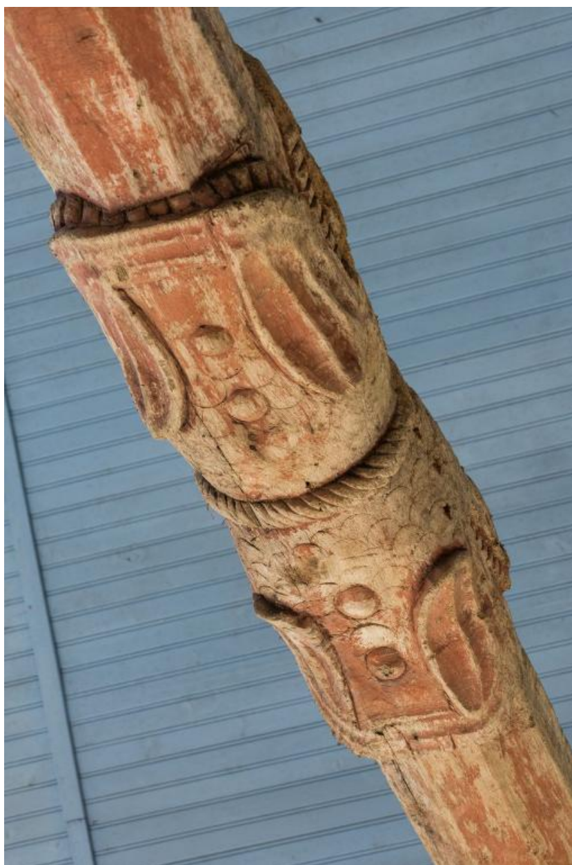
Vue de détail : deux engoulants au centre d'un entrail
